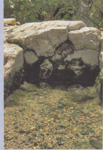
Çevresine hayat veren Osmanlı su kanalları
