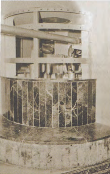
Zemzem kuyusunun üzerindeki pompa sistemi
