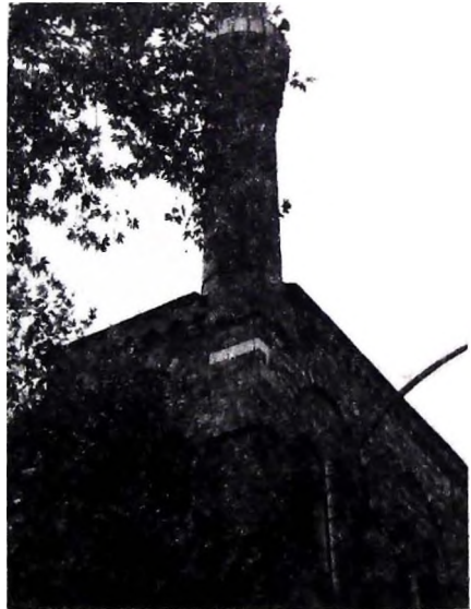
Sultan Murad'ın Bursa'da yaptırdığı Hüdevendigâr Camii
