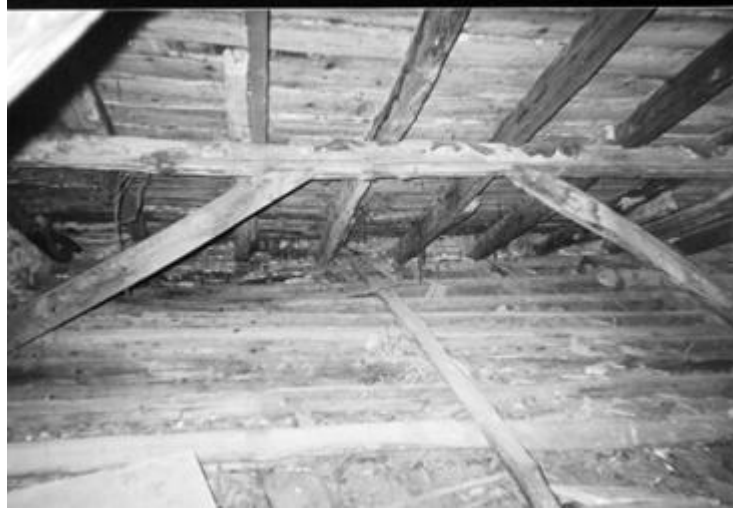
Teksir makinesinin bulunduğu çatı arası. Nazif Ağabey sabahlara kadar ayağında tokyo terliklerle Risaleleri bu tavan arasında tab' etmiş.
